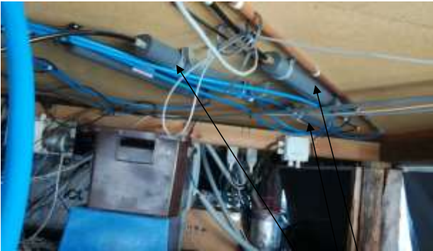
Kuva 8-4 Kaasujen päänäytelinjaa (kuvassa valkoinen, teflon letku) ja linjan vedenerotin (kuvan vasemmassa reunassa pystyasennossa oleva, läpinäkyvä, muovisylinteri) mittausaseman vanhan puolen alatilassa (yläkuva). Alakuvassa on pumppulinjojen (mustat nailonletkut) värinänvaimentimet (harmaat sylinterit) aseman alatilan katossa.
