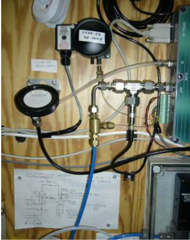
Kuva 2-30 Kyvetien kaasuanalysoittorin (LICOR-FO) pölysuodatinkotelo.
